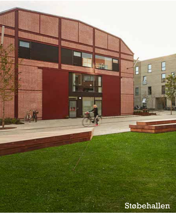
Valsehuset - Elektrohuset - Støbehallen
